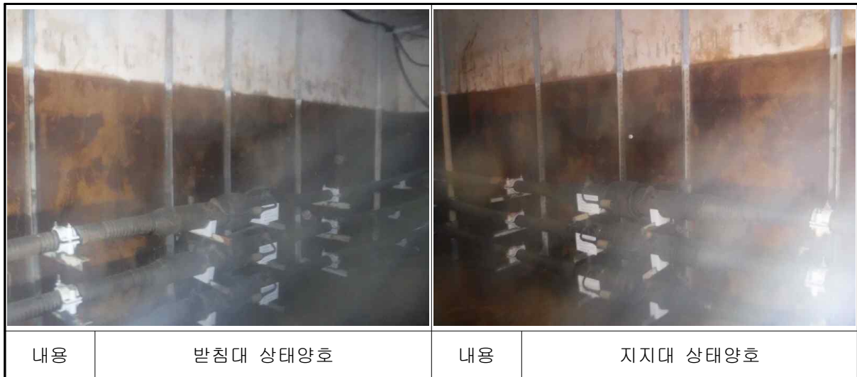
【사진 12.16】 부속 및 부대설비 현황
