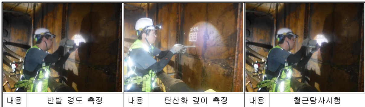
【사진 12.57】 지도능곡 재료시험 전경
